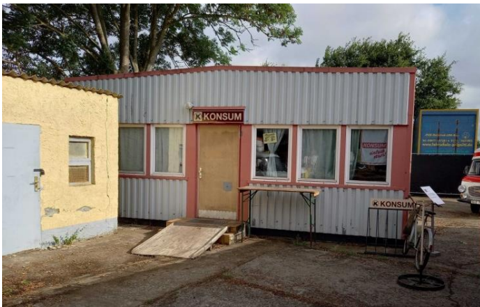
Abb. 17: Konsum-Kaufhalle: In Gegenden, in denen im Winter Transport-schwierigkeiten zu erwarten waren, mussten im Herbst Vorräte einlagert werden. Eine Erfahrung aus dem Katastrophenwinter 1978/79
